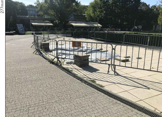
1. USZKODZENIA PŁYTY PLUSKOWISKA SPOWODOWANE NAJAZDEM SAMOCHODU DOSTAWCZEGO
